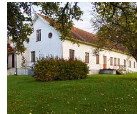
Lindberga prästgård var en av Hallands bäst bevarade prästgårdar, klassad motsvarande byggnadsminne. Församlingen har nu rivit byggnaden för att få ut maximal nyexploatering. Eftersom gården låg utanför detaljplan krävdes inte ens rivningslov.
